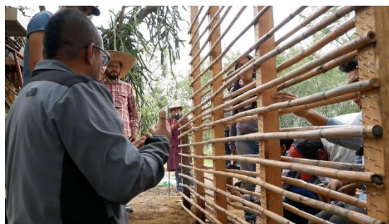
FIGURAS 7a Y 7b. Etapas de construcción de un muro de Bajareque (etapas trazo y armado de estructura). Fuente: Eugui Martínez Pérez (27/10/19)
