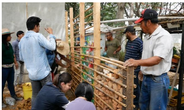
FIGURAS 8a Y 8b. Construcción de un muro de Bajareque (etapas armado de estructura y colocación de mortero de tierra). Fuente: Eugui Martínez Pérez (27/10/19)
