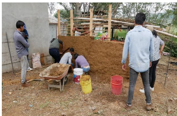
FIGURAS 8a Y 8b. Construcción de un muro de Bajareque (etapas armado de estructura y colocación de mortero de tierra). Fuente: Eugui Martínez Pérez (27/10/19)
