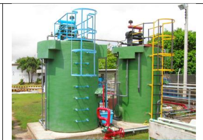
Foto: Planta compacta de tratamiento de aguas residuales RESIBLOC I Fuente: Aguas de Colombia, 2014.
