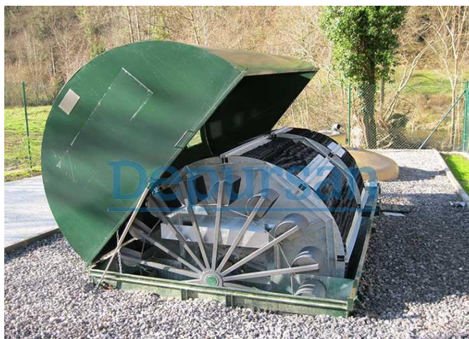
Foto: Planta compacta de tratamiento de aguas residuales. Fuente: Sande y Díaz, 2014.
