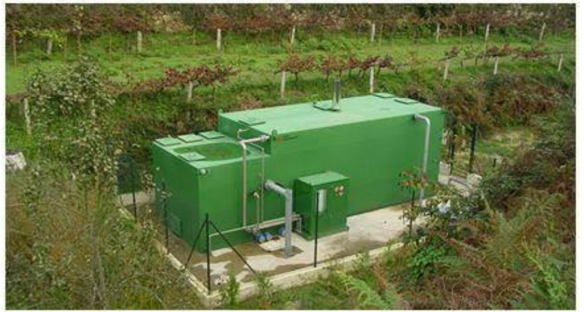
Foto: Planta compacta de tratamiento de aguas residuales. Fuente: Hidritec - España, 2014
