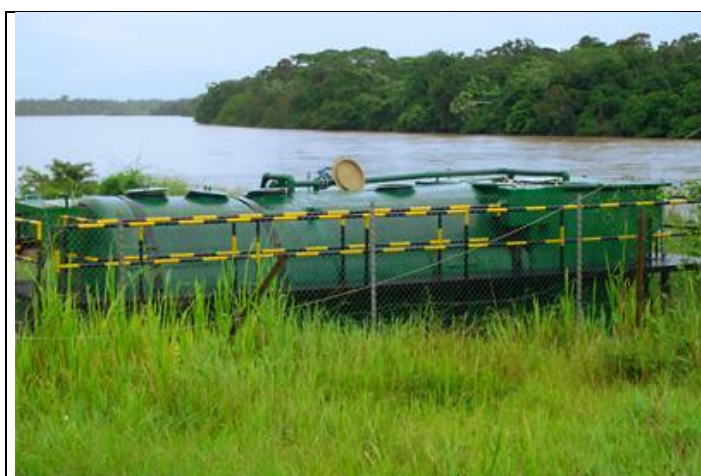
Foto: Planta compacta de tratamiento de aguas residuales RESIBLOC II Fuente: Aguas de Colombia Ltda, 2014.
