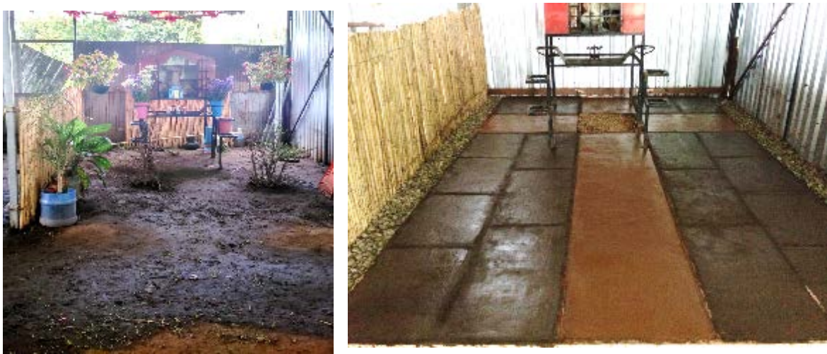
FIGURA 9. Vista de la capilla del tianguis “Gadoo Gush”, previo a la intervención constructiva del taller pisos con tierra (a) y piso terminado en el taller “Construyendo pisos con tierra” (b). Fuente: OSC, 2018.
