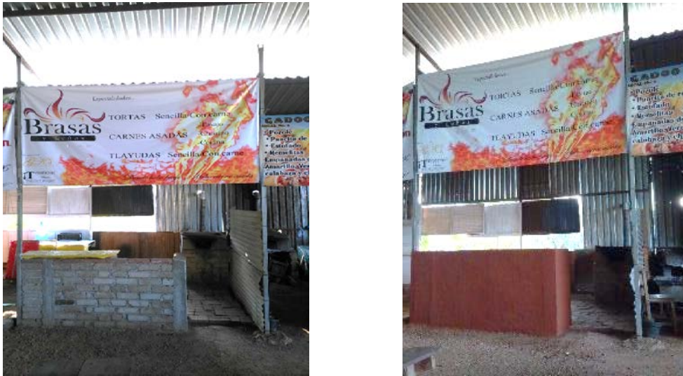
FIGURAS 10. Vista del local antes de la intervención (a) y con la aplicación de Ecotécnia aplanado con tierra en barra de local (b), “Tiangulis Gadoo Gush”, San Raymundo Jalpan, Oax.
