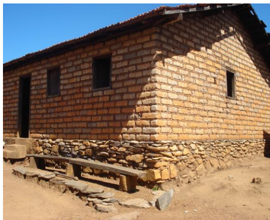
FIGURA 2. Casa construída com adobe: Valdirene Gomes dos Santos de Jesus, 2008.
